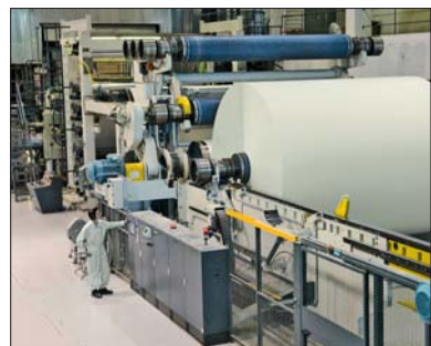
Im M-Real-Werk Simpele wird die Produktionskapazität um 80.000 Tonnen auf 300.000 Tonnen pro Jahr erhöht.
